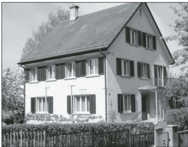
Bald werden am Haldenweg 16 die Handwerker das Sagen haben.
