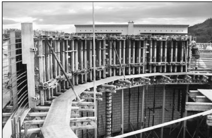
Der Bauarbeiten schreiten zügig voran.
