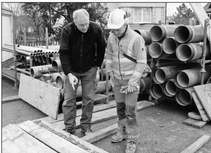
**Optimistisch: Geologe Hans Rudolf Graf (links) und Bohrmeister Robert Bissig begutachten die Bohrproben, welche ab einer Tiefe von 42 Metern Spuren von Grundwasser aufweisen.**
