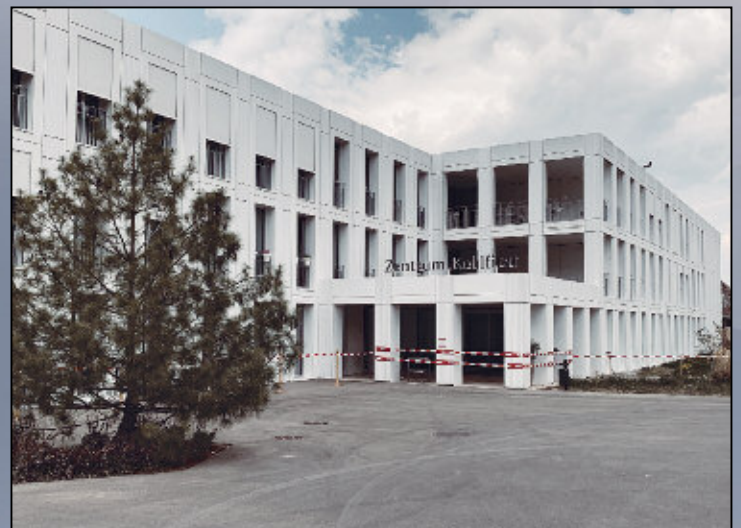
Das Zentrum Kohlfirst schottete sich ab.
