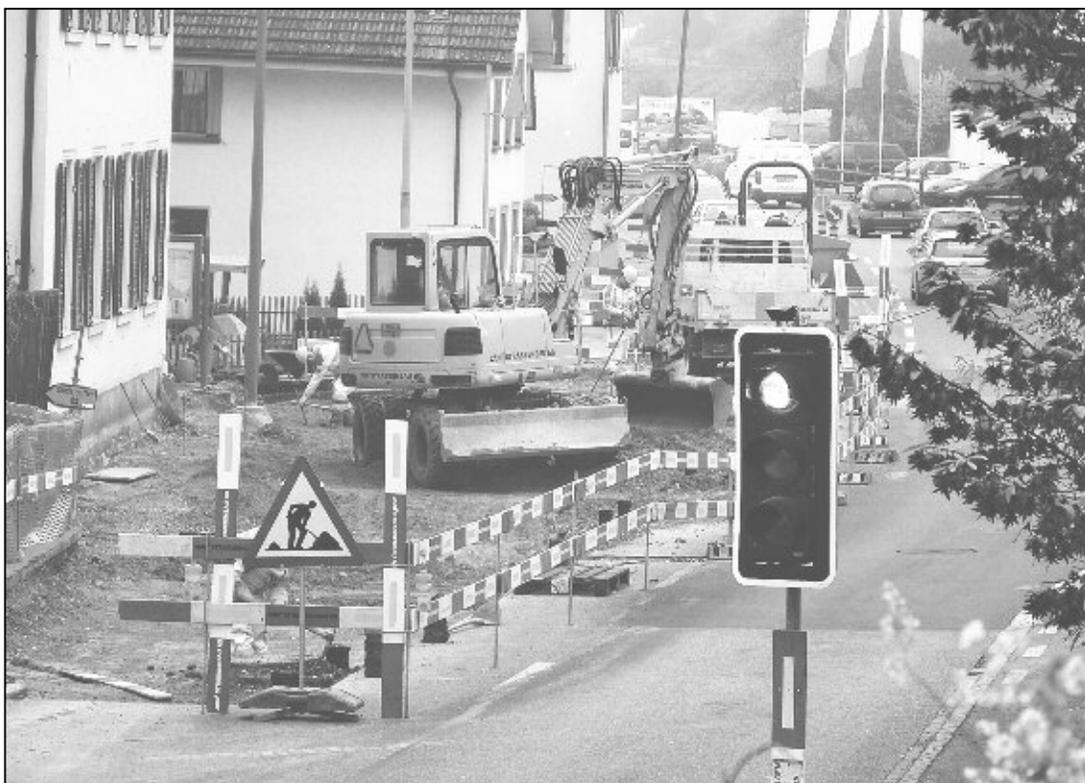
Mit schweren Baumaschinen und der unverzichtbaren Handarbeit werden vor dem Kindergarten und der Einmündung Rhygasse nicht nur Erdarbeiten ausgeführt, sondern eine grosse Anzahl Werkleitungen verlegt und erneuert.
