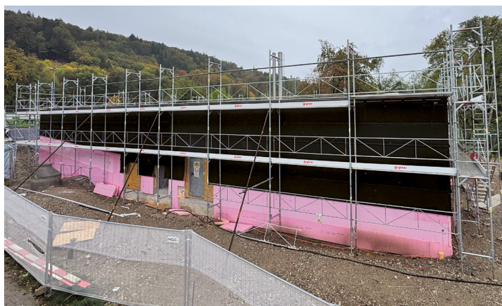
Die Heizzentrale: Aussen noch eine Baustelle – innen schreitet der Einbau der komplexen Technik zügig voran. Fotos: ks / zvg
