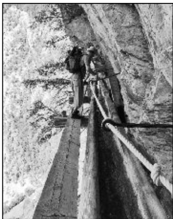
An der Felswand abgestützte Suone mit Fussweg.
