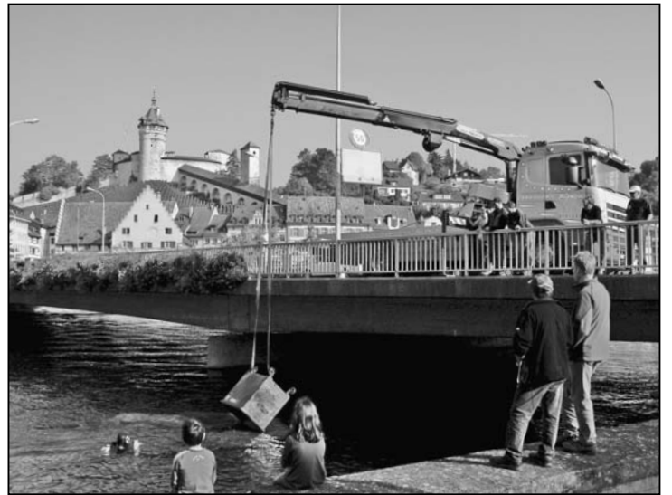
Manches kam an die Oberfläche.
