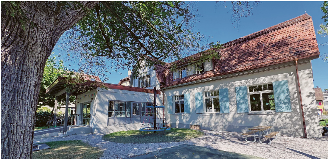
Der Kindergarten Haldenstrasse erstrahlt in neuer Schönheit, von aussen ...
