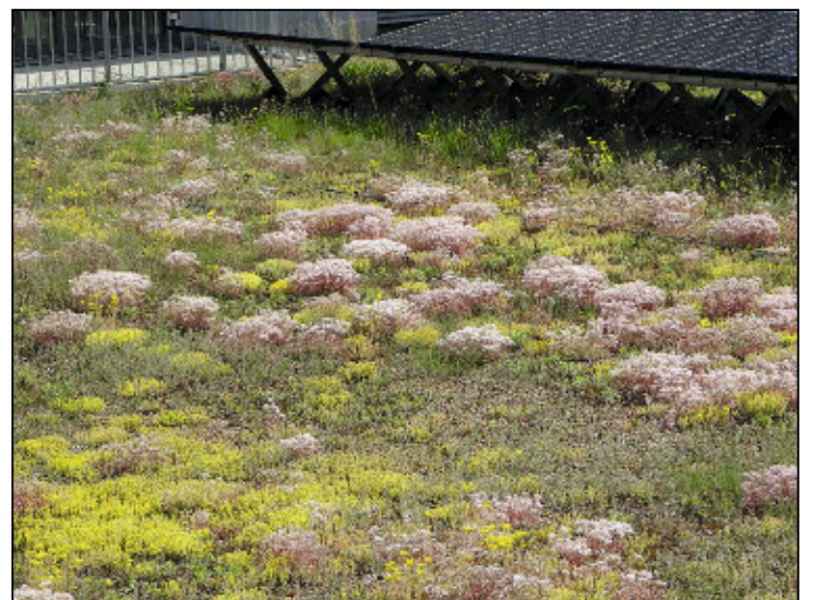
Verschiedenartig blühende Sedumpflanzen auf dem Dach vom COOP Rhymarkt Feuerthalen in Kombination mit Sonnenkollektoren.
