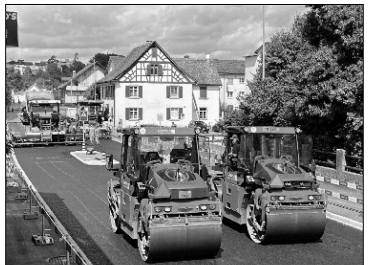
Nachdem der Asphalt-Heissmischbelag von den Belagsfertiger-Raupenfahrzeugen eingebracht ist wird er mit den Strassenwalzen verdichtet und ausgeglichen. Es waren bis zu fünf Walzen im Einsatz.
