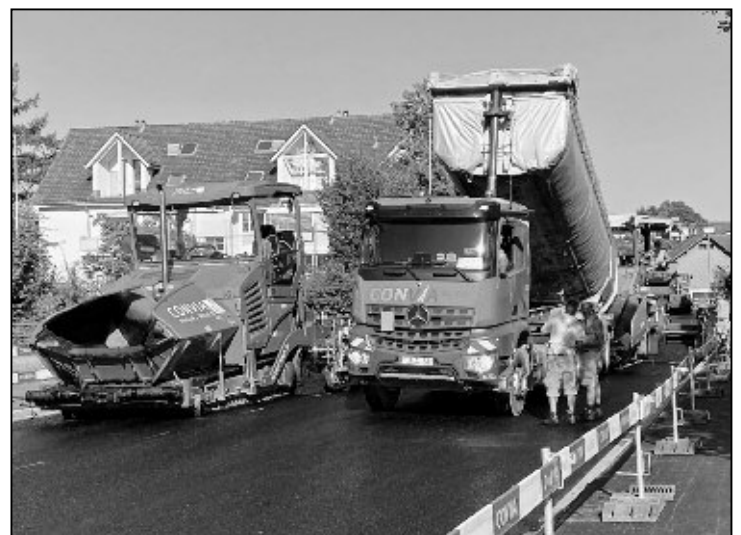
Links im Bild wartet ein Belagsfertiger-Raupenfahrzeug auf die Wiederbeladung von Heissmischgut, wobei der zweite Belagsfertiger rechts im Bild gerade beladen wird. Bei den Belagsarbeiten waren zwei Belagsfertiger und bis zu fünf Lastwagen mit Mischgut im Einsatz.
