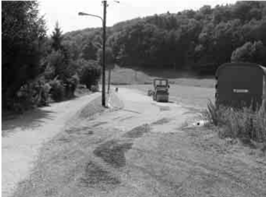
Letzte Woche wurde mit den Bauarbeiten für die Feinerschliessung im Gebiet Ebni begonnen.
