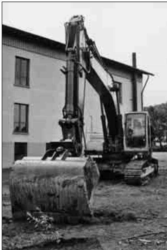
Ein gelungener Spatenstich...
