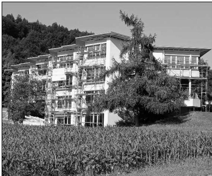
Die eingerüstete Nordost-Seite des Schulhauses Stumpenboden. Zug um Zug wird hier Fenster für Fenster ersetzt.
