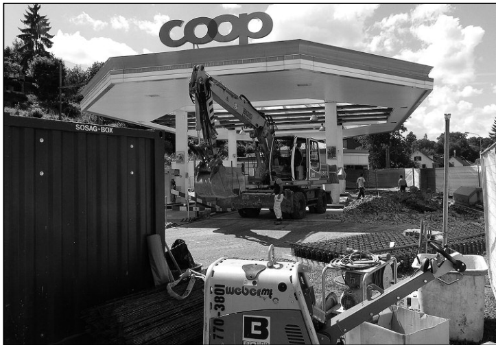
Die Coop-Tankstellen-Baustelle in Langwiesen.
