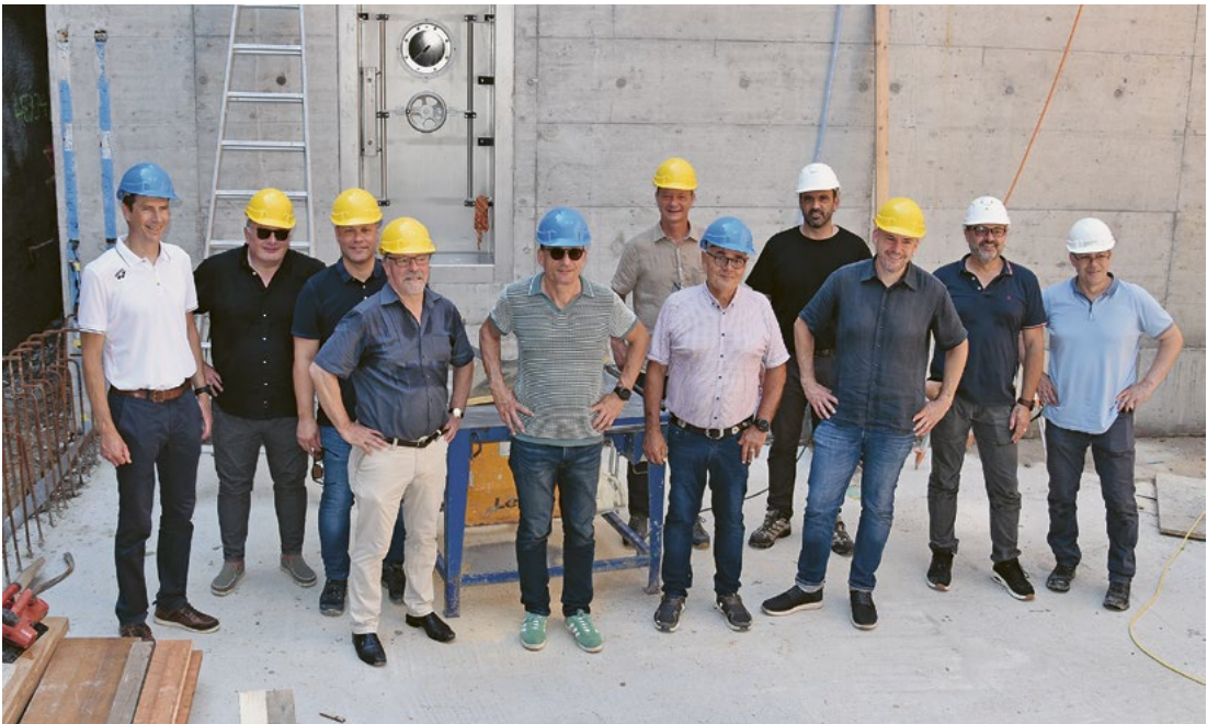
Die Feuerthaler Behörden-Vertreter und Projektleiter Ehrensberger (rechts aussen) im künftigen Schieberhaus. Hinter der Drucktüre in der Betonwand lagern bereits 850 000 Liter Wasser zur Dichtigkeitsprüfung der rechten Kammer.
