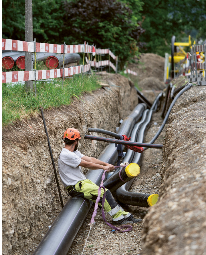
In der Feldstrasse wurde in der vergangenen Woche die Hauptleitung eingezogen.
