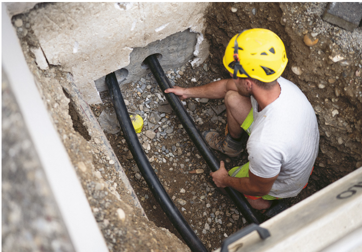
Anschluss an die Liegenschaft: Je ein Rohr für die Zuleitung der Wärme und die Rückführung des abgekühlten Wassers werden verlegt.
