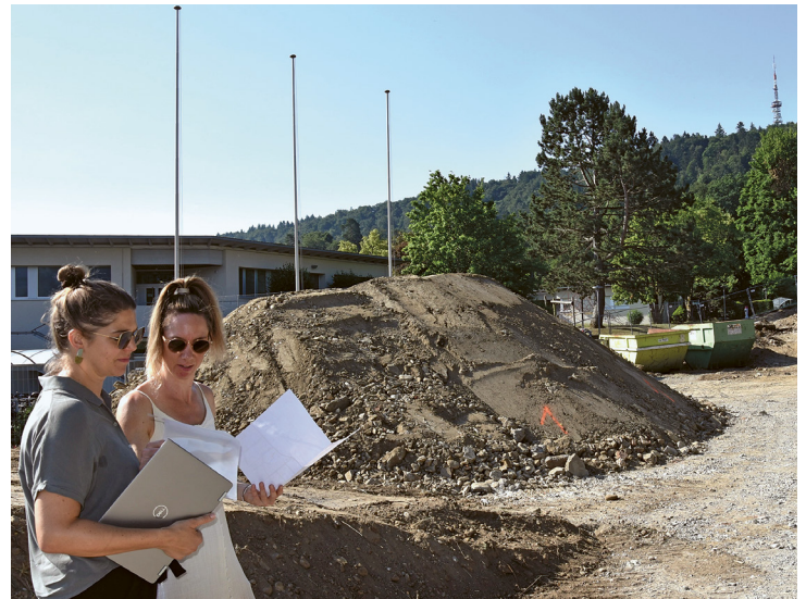
Die Verantwortliche für Marketing und Kommunikation der Etawatt AG, Martina Heuberger (links) und Projektleiterin Alexa Ruff, informieren den Feuerthaler Anzeiger über den Baufortschritt. Im Hintergrund sind die Aushubarbeiten für die Heizzentrale in vollem Gang. Fotos: zvg / ks
