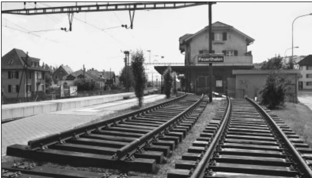
Neue Streckenführung? Nein, die neuen Geleise beim Feuerthaler Bahnhof liegen hier für die Montage bereit.
