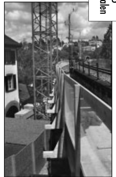
Auch auf der Feuerthaler Seite des Viaduktes sind die Vorbereitungsarbeiten schon weit fortgeschritten. Fotos: ks.
