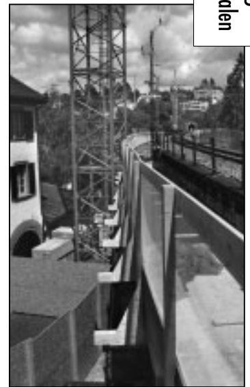
Auch auf der Feuerthaler Seite des Viaduktes sind die Vorbereitungsarbeiten schon weit fortgeschritten. Fotos: ks.
