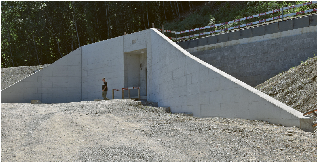
So präsentiert sich der Eingang des fertiggestellten Hochreservoirs heute. Anschliessend wird hinter den markanten Flügelmauern aufgeschüttet und aufgeforstet.
