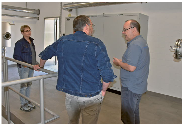
Auch Gesamtbauleiter Hannes Ehrensberger war ein gefragter Mann. Im Schieberhaus erklärt er Interessierten die Funktionsweise der Anlage.
