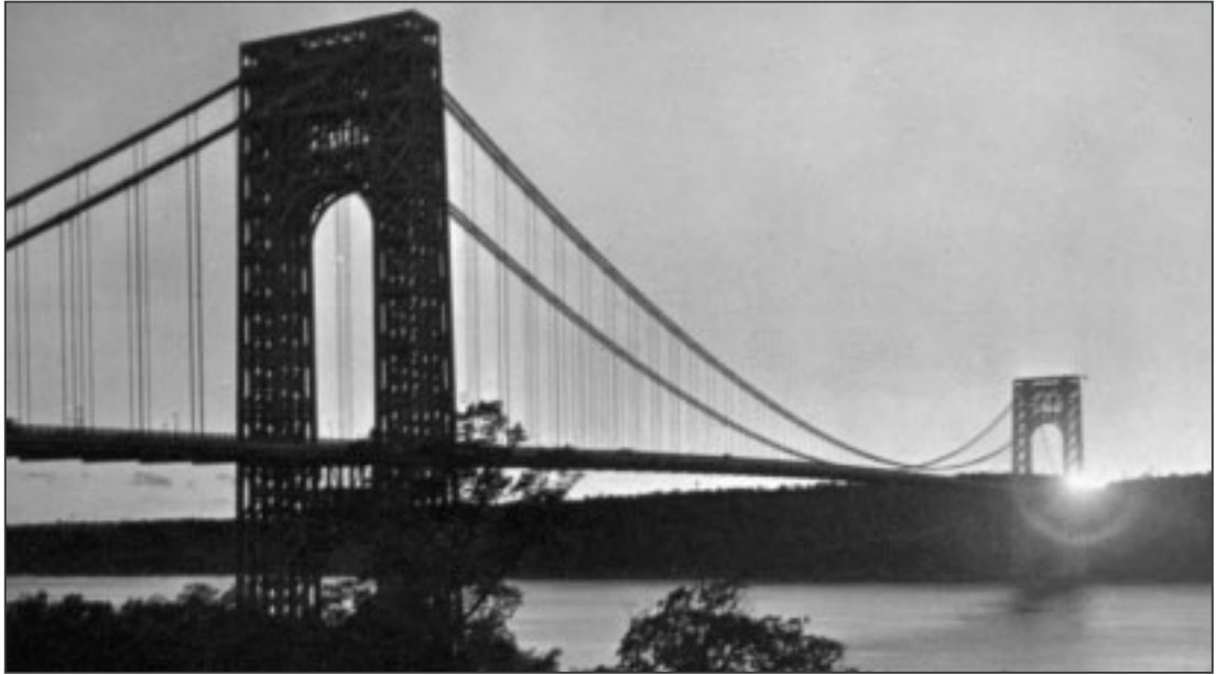
Die George Washington Bridge war von 1931 bis 1937 mit 1067 Metern Spannweite die längste Hängebrücke der Welt.
