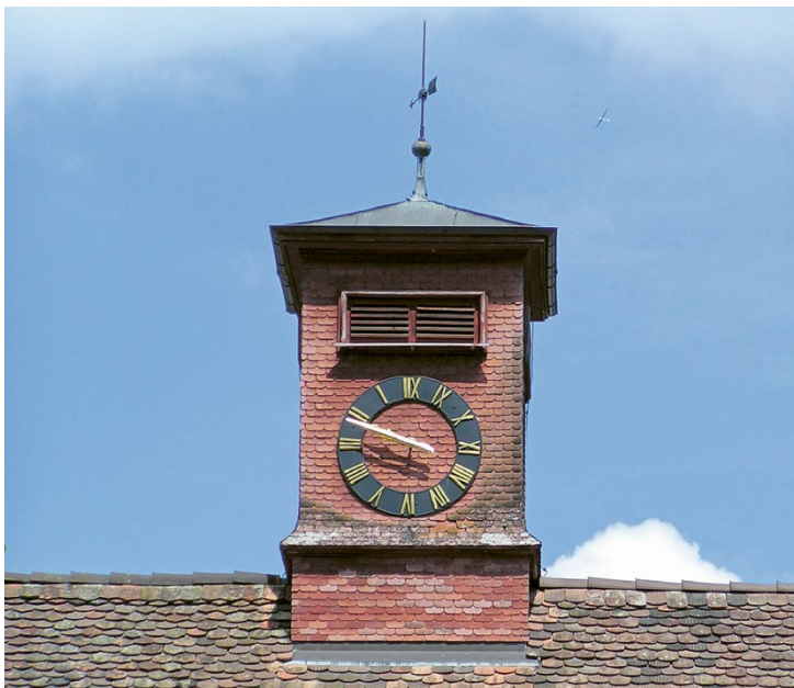
Das Dachreiter-Türmli mit Zifferblatt, Schallaustrittöffnung und Windfahne.
