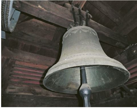
Ansicht der Glocke am drehbaren Tragbalken (Joch) hängend mit Klöppel.
