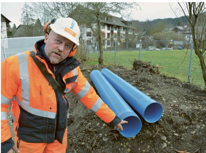
Bohrmeister Bissig erklärt die Funktion der Filterrohre mit den Wassereinlassschlitzen. Durch diese wird am Schluss die Pumpleitung mit der Hochleistungspumpe in die wasserführende Schicht abgesenkt. Fotos: ks
