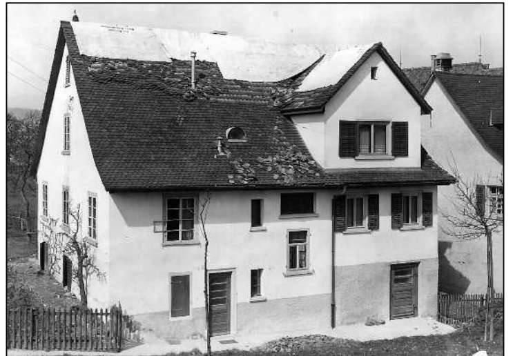
Das Elternhaus von Gerhard Wüst an der Uhwieserstrasse 18 wurde nach dem Bombentreffer vorerst notdürftig mit Blachen abgedeckt.
