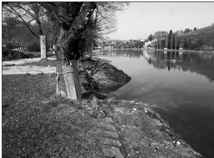
Beginn der Bauarbeiten – Im Vordergrund ist noch der alte Steinsatz sichtbar.
