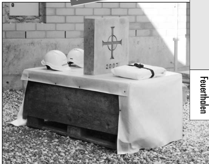
Metallkasten, Dokumentenpaket und Grundstein.
