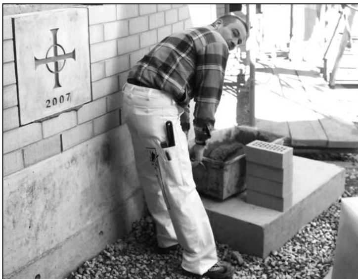
Der Grundstein wird eingemauert.
