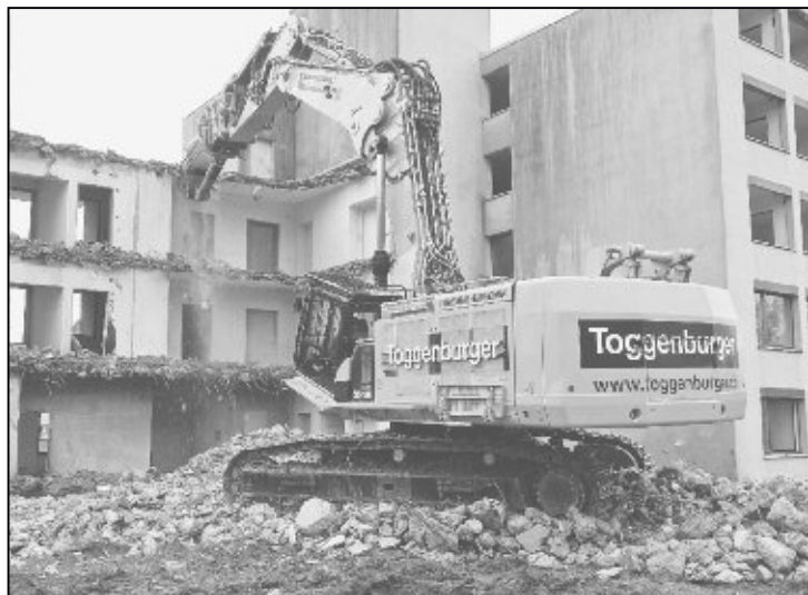
Mit dem Baggervorsatz, einer hydraulischen Beisszange, wird Stück für Stück von den Decken abgezwickelt.
