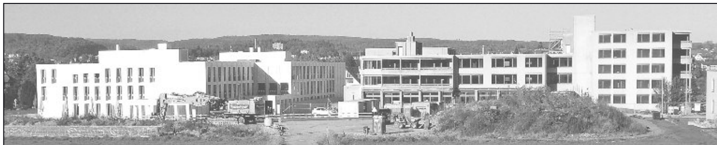
Ein Erinnerungsbild von Alt- und Neubau wie es heute bereits nicht mehr zu sehen ist. Der vor dem Neubau platzierte 120-Tonnen-Bagger wartet bereits auf seinen Einsatz.
