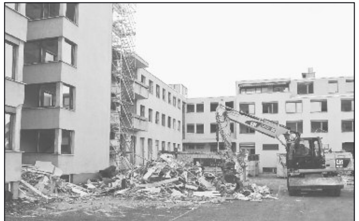
Der Hinterhof wird als Lageplatz für die anfallenden Baumaterialien genutzt, die mit einem kleineren Bagger in die Mulden zum Abtransport geladen werden.
