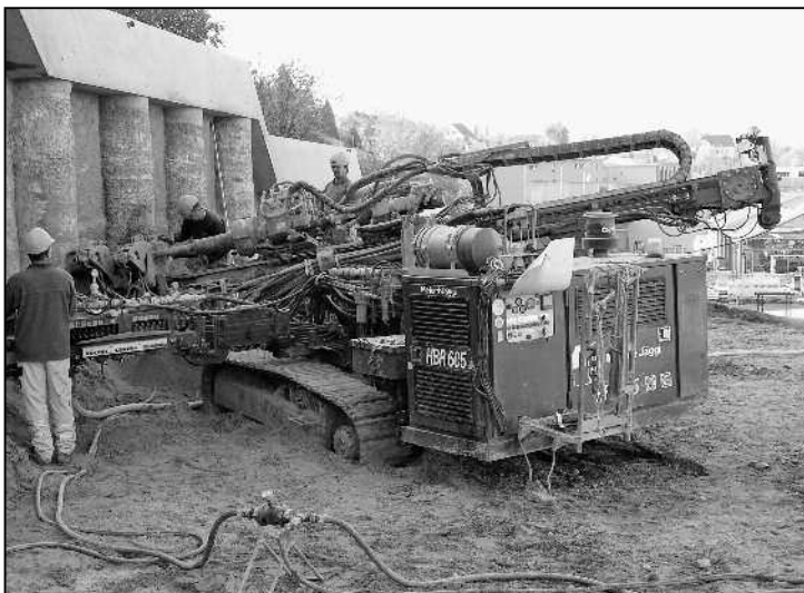
Mit dieser fahrbaren Bohrgrossmaschine werden an den Betonpfählen die Mantelrohre für die Erdanker gebohrt und vorangetrieben.
