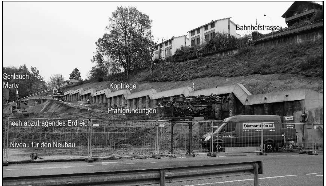
Diese Bild veranschaulicht den aktuellen Stand der Stützmauerfertigung von oben nach unten, wobei hier erst zirka 20 Prozent der Stützmauer freigelegt sind und daher noch sehr viel Erdreich abgetragen werden muss, um auf das Niveau des Neubau-Baugrunds zu gelangen.
