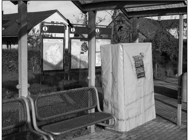
Ein Billettautomat in Plastik verpackt, ausser Betrieb, und eine fehlende Glaswand warten auf ihre Wiederinstandsetzung.
