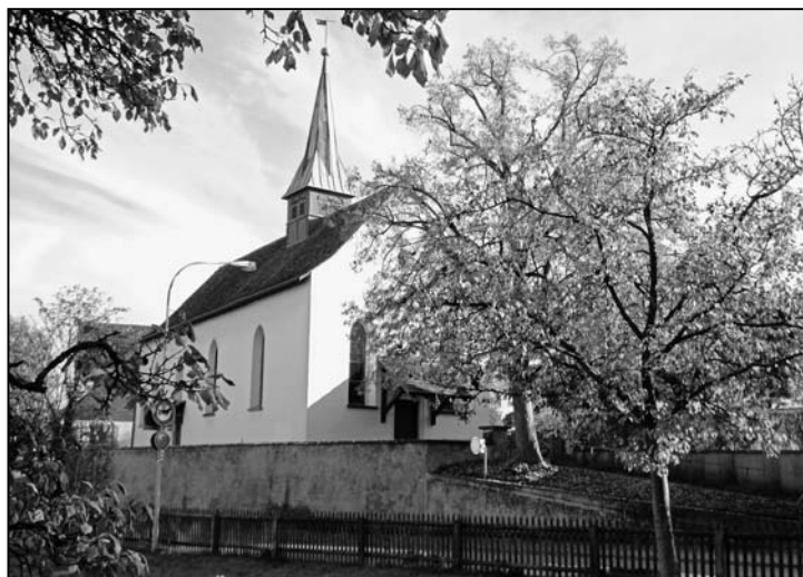
Wichtige Sanierungsarbeiten stehen an: Reformierte Kirche Feuerthalen.
