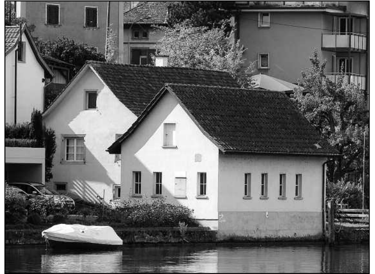
Direkt am Rhein gelegen: das Gebäude mit dem Grundwasserpumpwerk.
