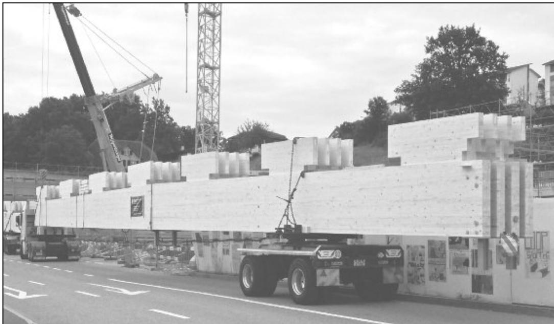
*Einer der beiden Spezialtransporte, wobei die Holz binder das Hauptelement des Fahrzeuges bilden, die auf dem LKW Motorteil und hinten auf einem 2-achsigen Fahrteil aufliegen.*
