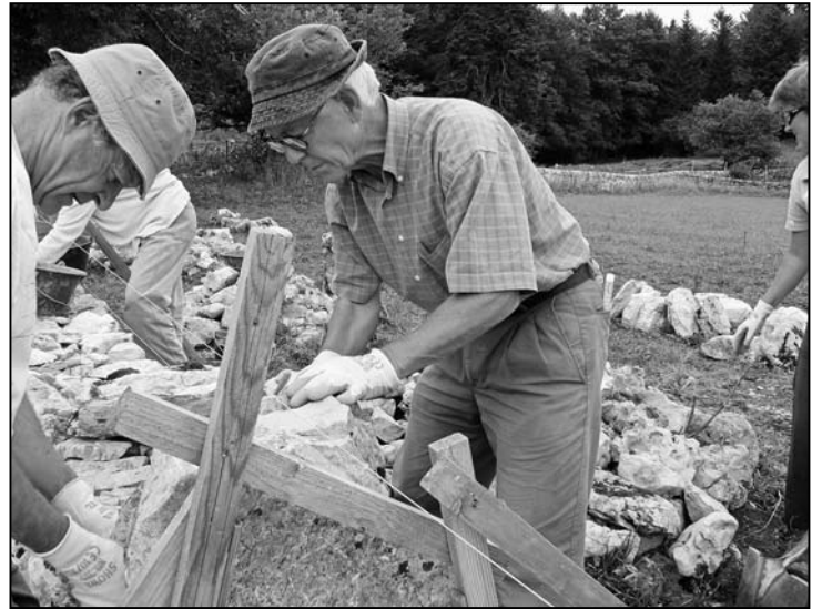
Jakob Brunner beim Bau einer Trockenmauer auf dem Chaumont.
