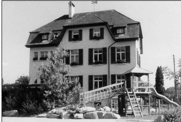
Das Schulhaus Langwiesen, bei der Einweihung der neuen Zivilschutzanlage und dem Kinderspielplatz 1987.
