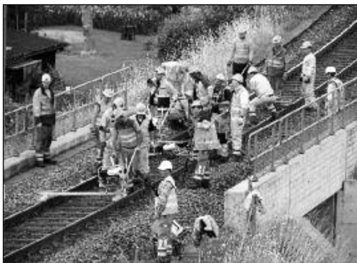
Wie eine Traube aus orange gekleideten Bahnarbeitern, verrichten zwei Rotten der SBB den Schienenunterhalt.
