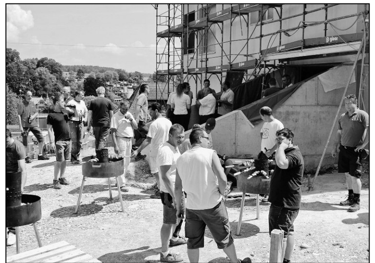
Grillieren statt betonieren auf der Baustelle.
