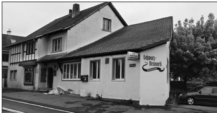
Bald kehrt hier wieder Leben ein: Restaurant Schwarzbrünneli.
