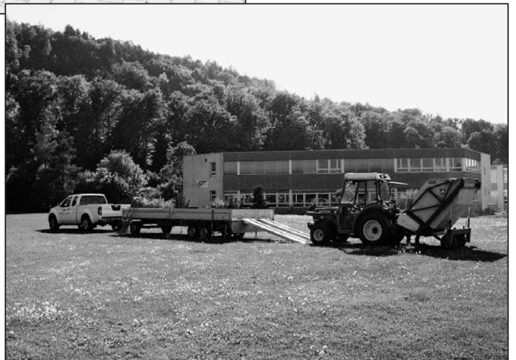
Die Arbeiten sind in vollem Gange.
