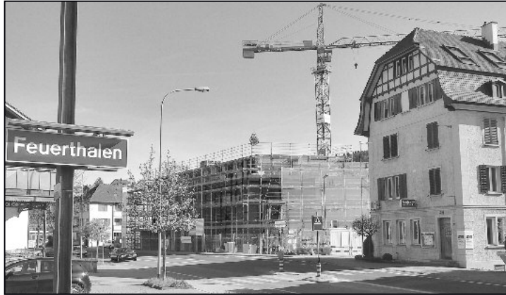
Mit dem noch eingestützten Neubau mit Richtbaum ist schon das endgültige Bauvolumen im Einklang mit den bestehenden Häusern sichtbar.
