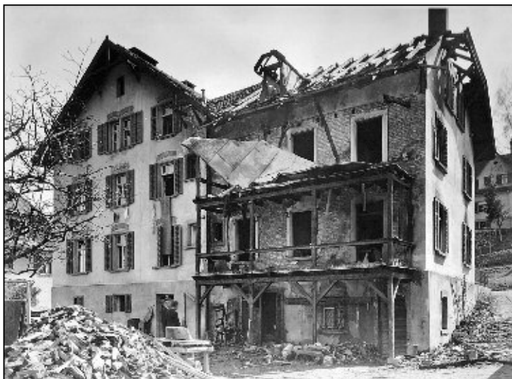
Das Wohnhaus an der Zürcherstrasse 114 erhielt einen Volltreffer. Das Gebäude steht heute noch und wurde vor Kurzem wieder renoviert.
